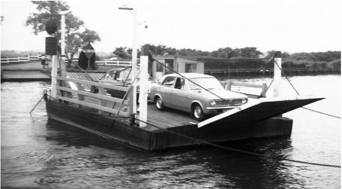
Die Reedham Fähre in Norfolk GB ist typisch für viele Fluss-Übergänge in England und Deutschland. Schon vor 1950 (Bild) beförderte die Fähre mehrere Autos und Tonnen aufs Mal und wurde von Hand gekurbelt. Heute hat sie einen Motorantrieb und befördert bis zu 3 Autos oder 12 Tonnen.
